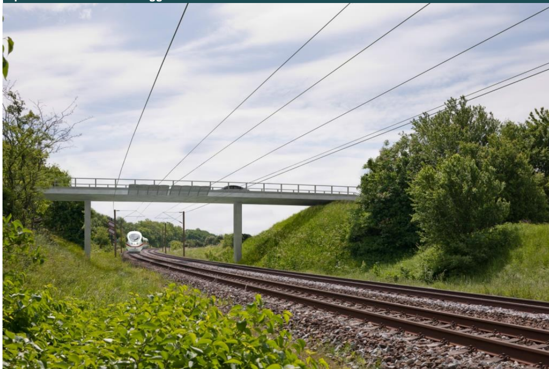
FIGUR 2.3 Der opsættes master for hver 30 – 100 m, og mere end 100 broer ombygges for at gøre plads til kørestrømsanlægget
